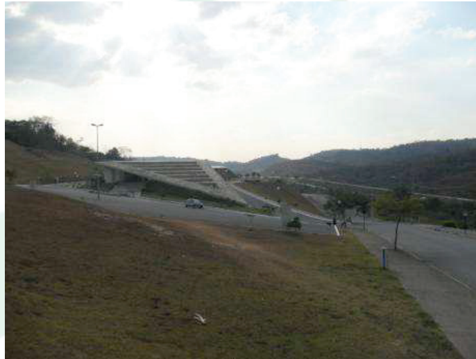
Foto 3: Vista do estacionamento
