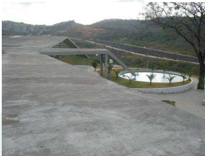
Foto 14: Vista superior da entrada para os Velórios
