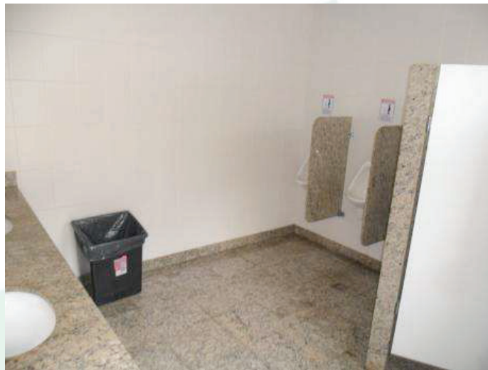
Foto 28: Vista interna sanitário masculino
