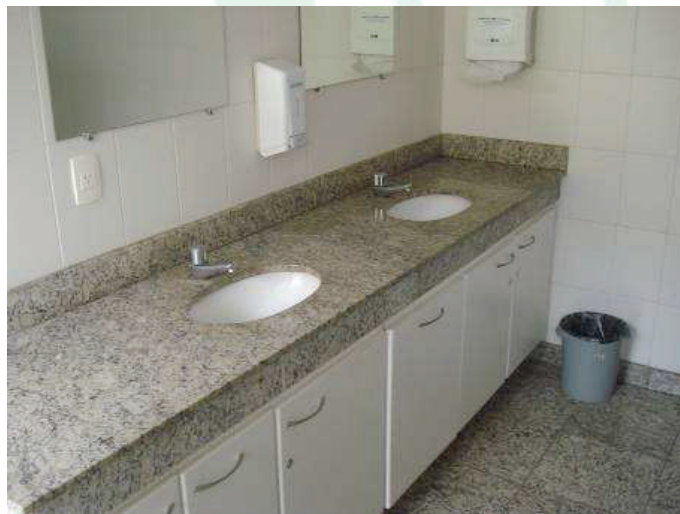
Foto 27: Sanitário com detalhe da bancada
