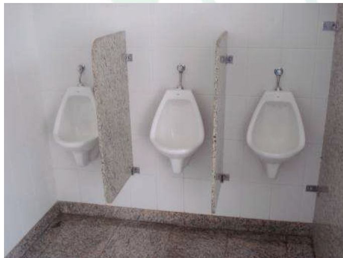
Foto 29: Vista interna sanitário masculino
