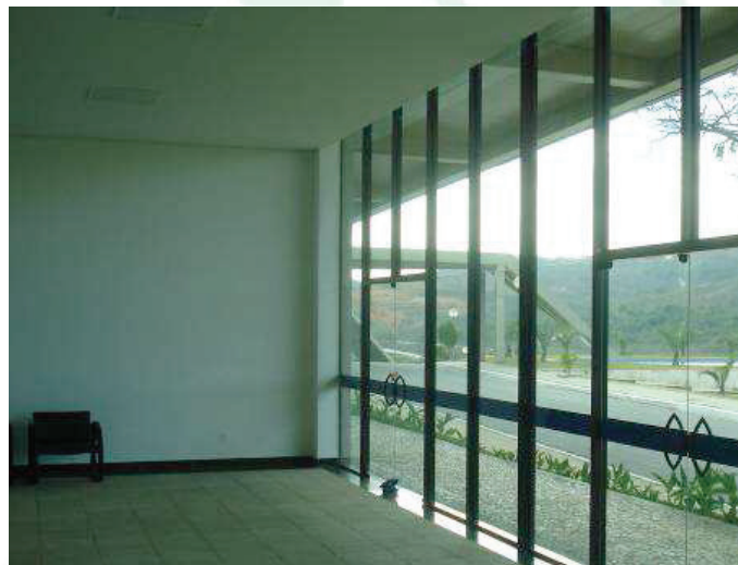
Foto 21: Vista interna do Velório 01
