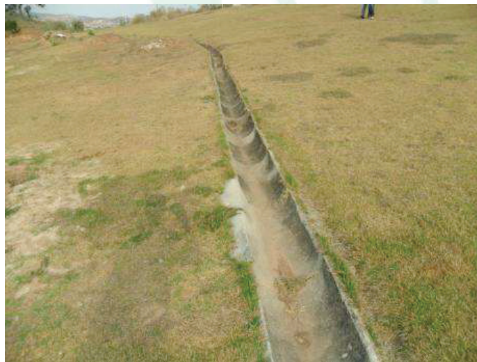
Foto 11: Detalhe da área de escoamento pluvial
