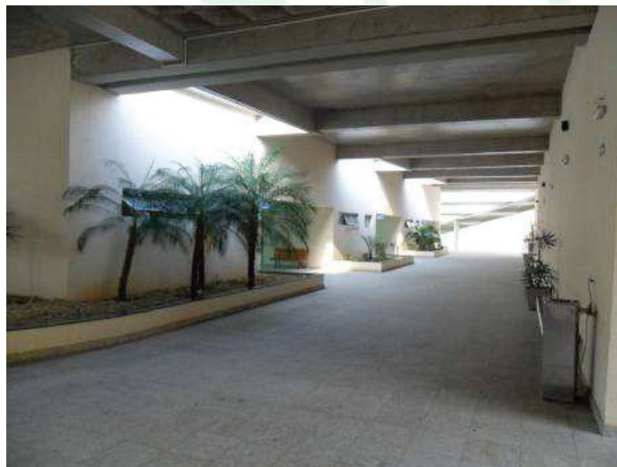
Foto 18: Hall de entrada para os Velórios
