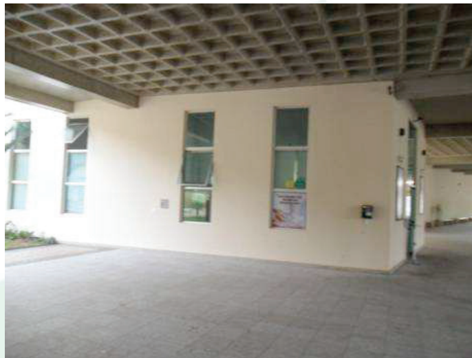
Foto 17: Hall de entrada para os Velórios
