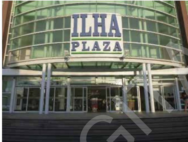
ASPECTO DA FACHADA DO AVALIANDO – FRENTE
