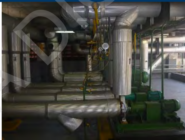
ASPECTO INTERNO DO AVALIANDO – COBERTURA – ÁREA TECNICA
