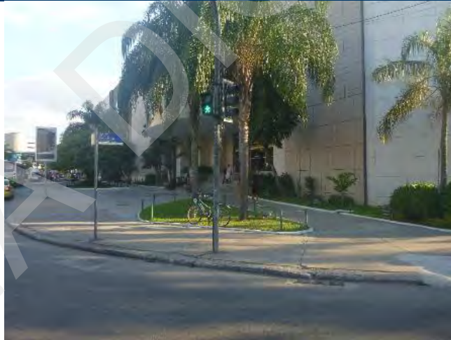
ASPECTO DA FACHADA DO AVALIANDO
