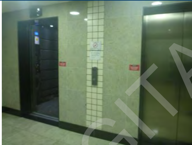
ASPECTO INTERNO – PISO G1 – ELEVADORES DE ACESSO
