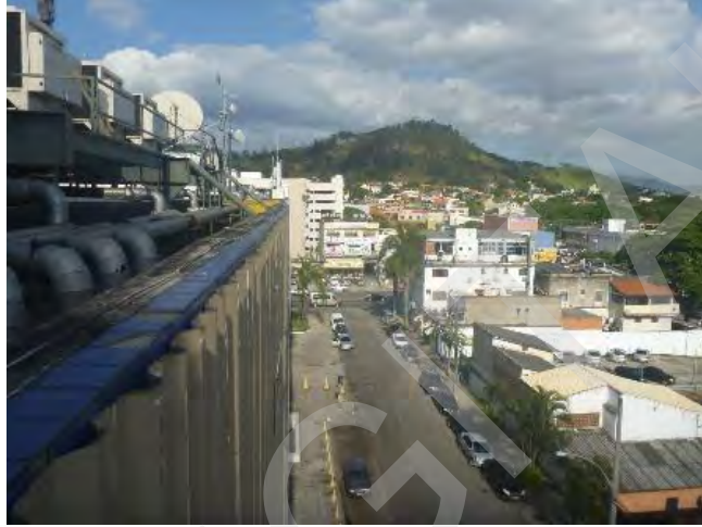
ASPECTO DO ACESSO AO WEST SHOPPING CENTER - EDIFÍCIO MATRIZ – RUA NOVA BETÂNIA
